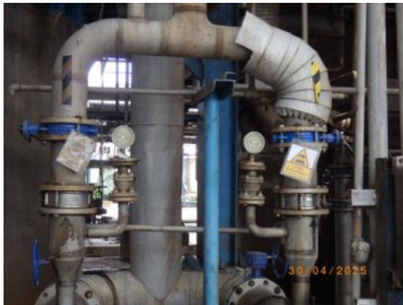
รูปที่ 2-43 ติดตั้ง Pressure และ Temperature Transmitter ที่ระบบการกลั่น
