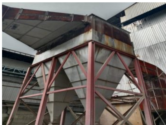
รูปที่ 2-3 ระบบบำบัดแบบ Multi cyclone
