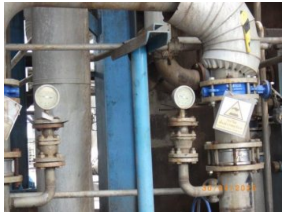
รูปที่ 2-43 ติดตั้ง Pressure และ Temperature Transmitter ที่ระบบการกลั่น
