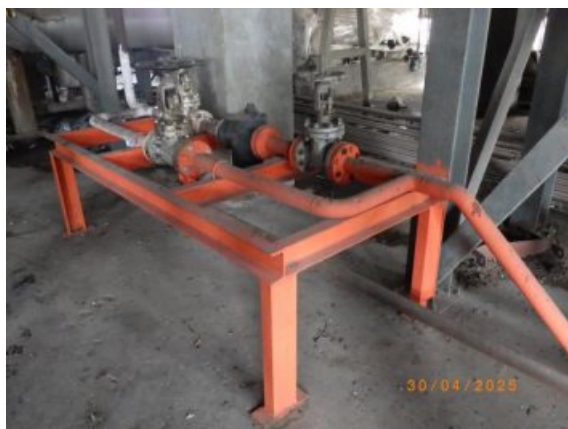
รูปที่ 2-53 ล้นกันกลับ (Check Valve)
