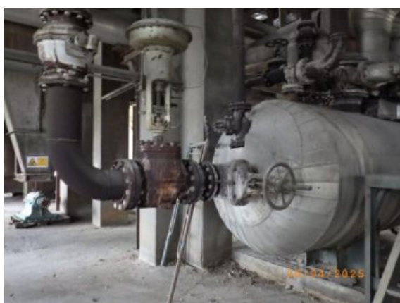
รูปที่ 2-55 ล้นปิดเปิด (Blow Down Valve)
