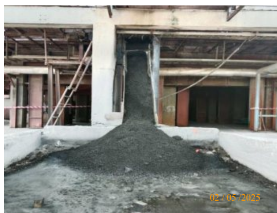
รูปที่ 2-24 ภาพขณะรองรับผงฝุ่นจากการบำบัดด้วย Cyclone
