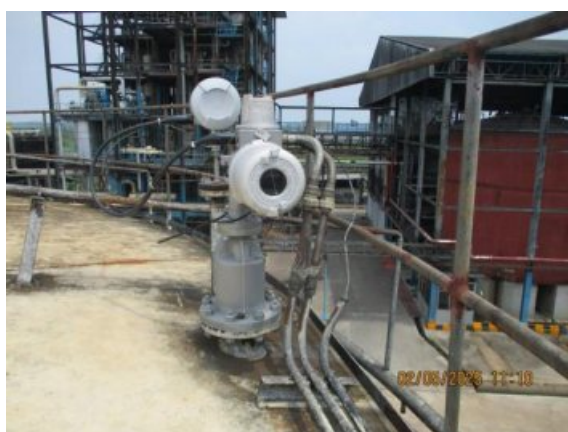
รูปที่ 2-5 เครื่องวัดระดับ Low level transmitter และ High level transmitter ของถังเก็บสำรองเอทานอล
