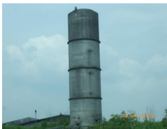
รูปที่ 2-9 การติดตั้งตัวเผาก๊าซส่วนเกิน (Flare)
