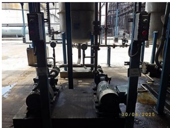
รูปที่ 2-51 Boiler Feed Water Pump
